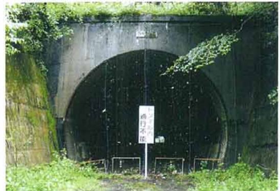
写真7. 全面金属ネットで封鎖されたトンネル (真庭郡湯原町, 2007年8月29日).
