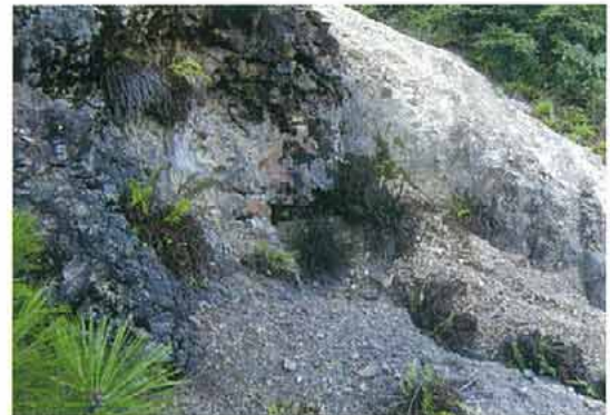
写真6. 崩落により入口が閉ざされた廃坑 (和気郡吉永町, 2007年9月26日).
