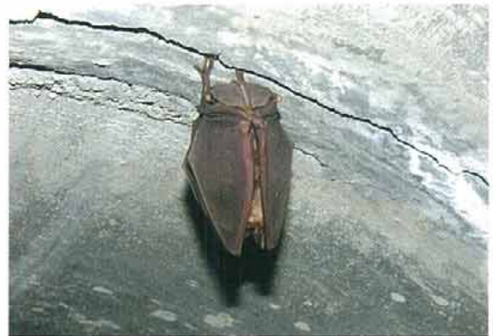
写真8. 暗渠天井部のわずかな亀裂を利用してキクガシラコウモリ (真庭郡新庄村, 2007年10月21日).
