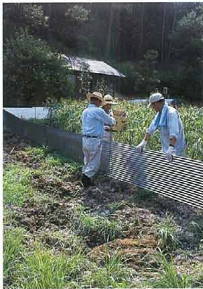
シルバーさんによるイノシシよけトタン柵の設置(2002.8.23)
